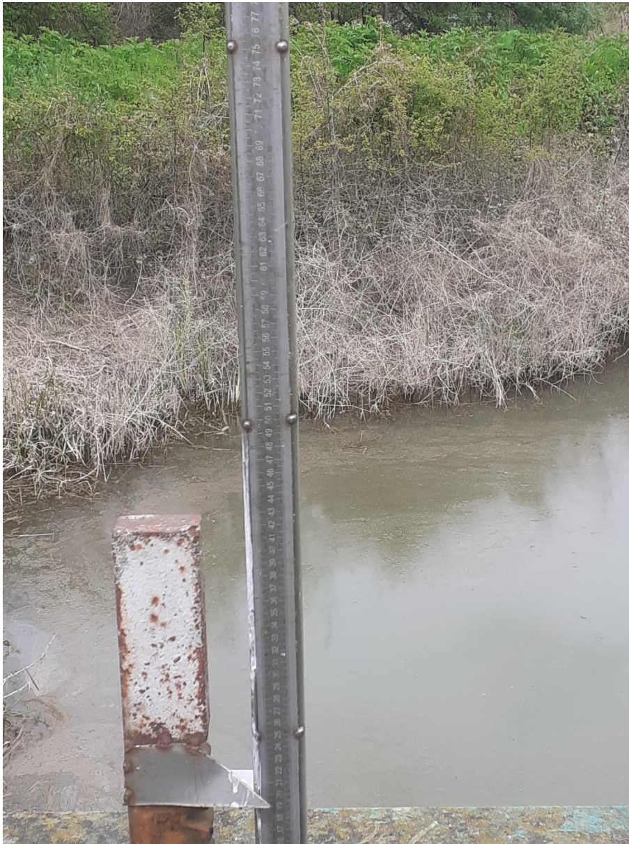
Barre de recopie de la vanne côté canal
