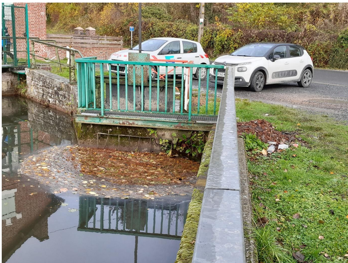
Vanne permettant l'alimentation de la rigole de l'Oise
