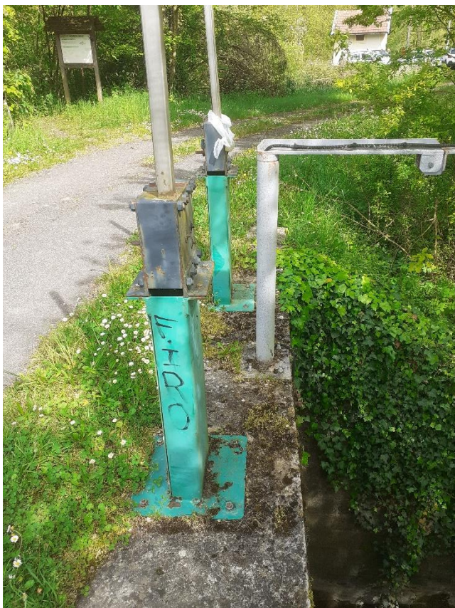
2 vannes levantes et sonde amont
